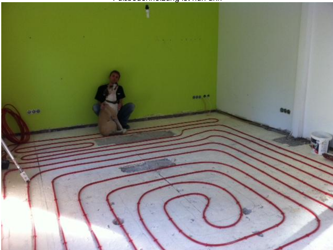
Fußbodenheizung ist nun drin
